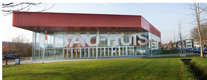
Geluidswerende deuren in beurs- en evenementencentrum Bau-huis in Sint-Niklaas
