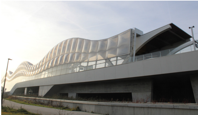
Zicht op de Arsenaalzijde
