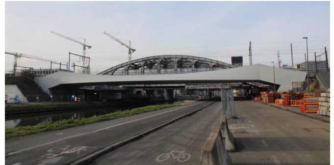
De Vierendeelbruggen, deels achter de nieuwe spoorbrug
