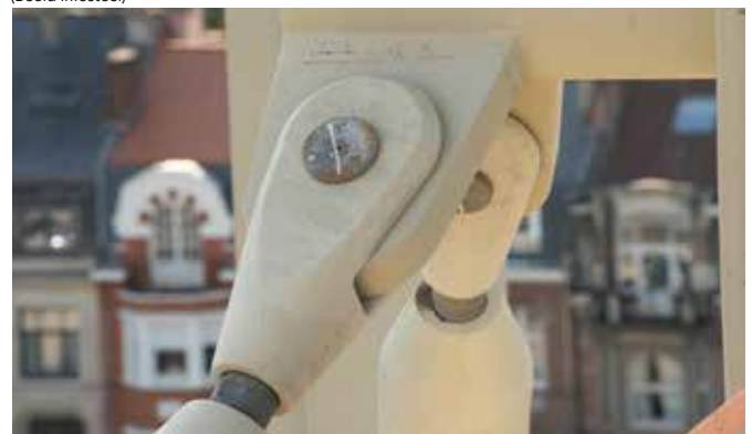
Detail van de cellenliggers, de onderzijde van de staalplaat-betonvloer en een knoop van het exoskelet. (Beeld infosteel)
