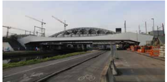
De Vierendeelbruggen, deels achter de nieuwe spoorbrug
