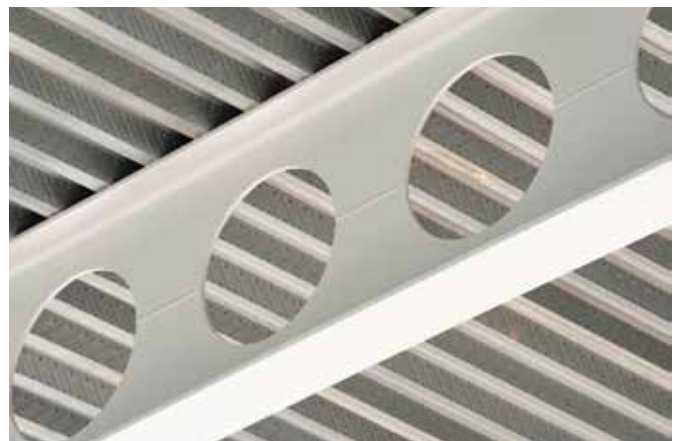
Detail van de cellenliggers, de onderzijde van de staalplaat-betonvloer en een knoop van het exoskelet. (Beeld infosteel)
