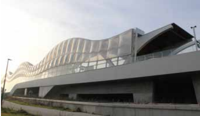
Zicht op de Arsenaalzijde
