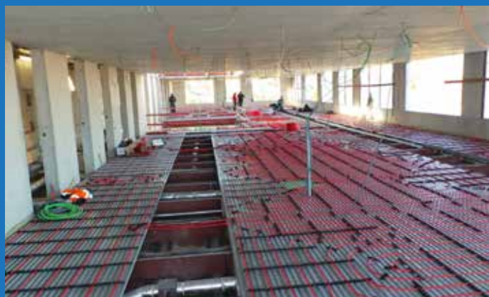
REPPEL BV SPECIALIST BUILDING PRODUCTS – Zwaluwstaartplaten in politiebureau Koksijde
