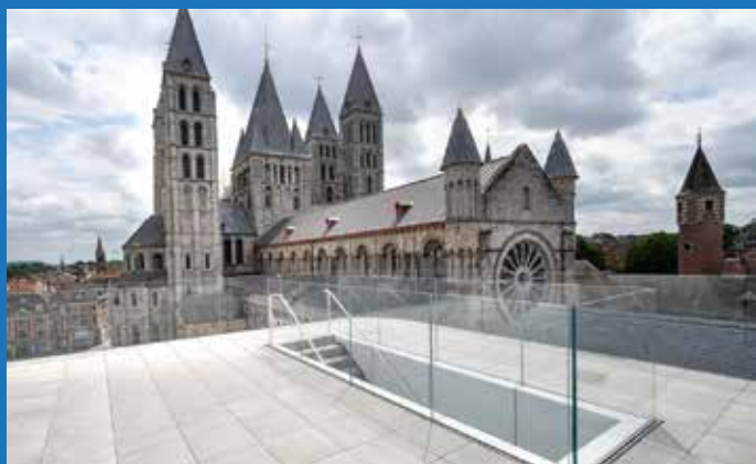
ZOONTJENS BELGIE NV – Dakterras in Doornik
